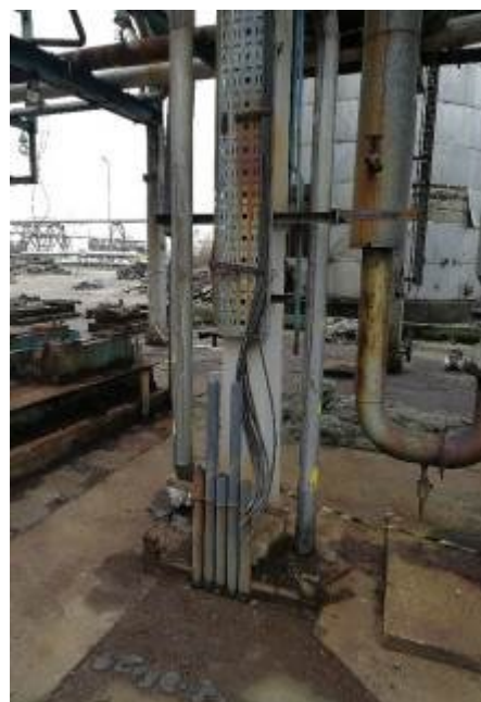
Слика 12. Примјер мјеста на ком је потребно извршити демонтажу постојећих кабловских каналица
